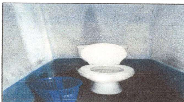
FOTO NO 4. CAMBIO DE ACCESORIOS DE SANITARIOS.
