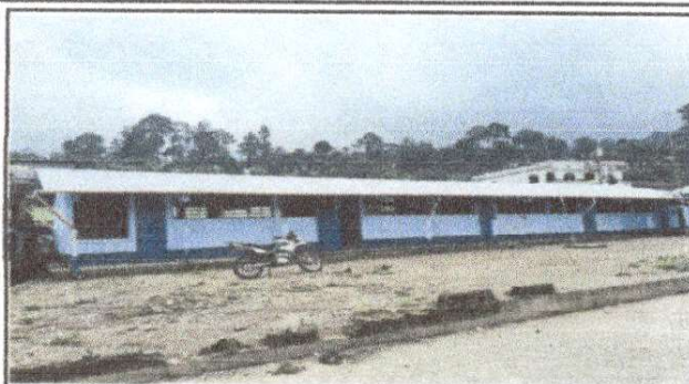
FOTO: SUSTITUCION DE TECHO.
