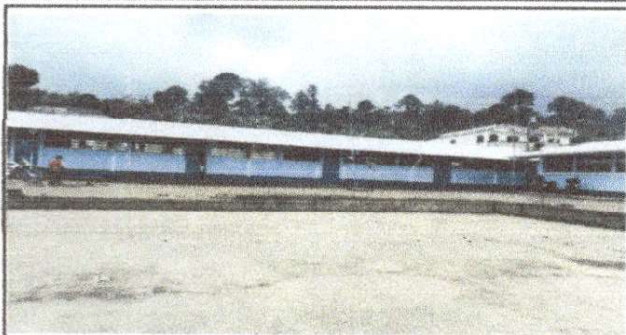
FOTO 1: SUSTITUCION DE TECHO
