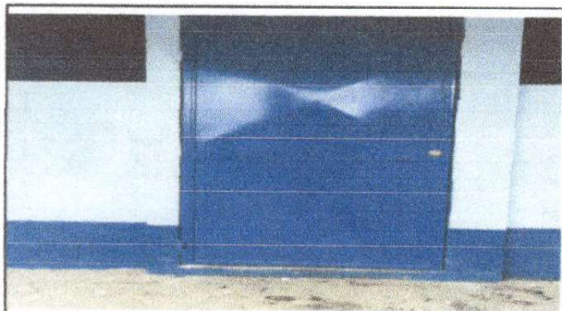
FOTO NO 3: SUSTITUCION DE PUERTA 1.
